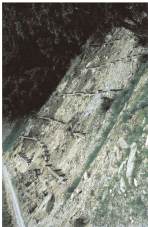
Palizzata in legname ed inerbimento con coltre protettiva di paglia e bitume (fase di realizzazione)
