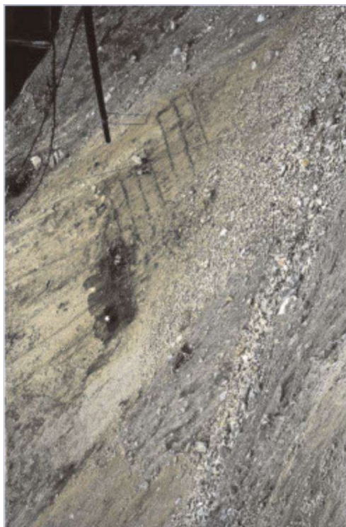
Gradinata con tallee (fase di realizzazione)
