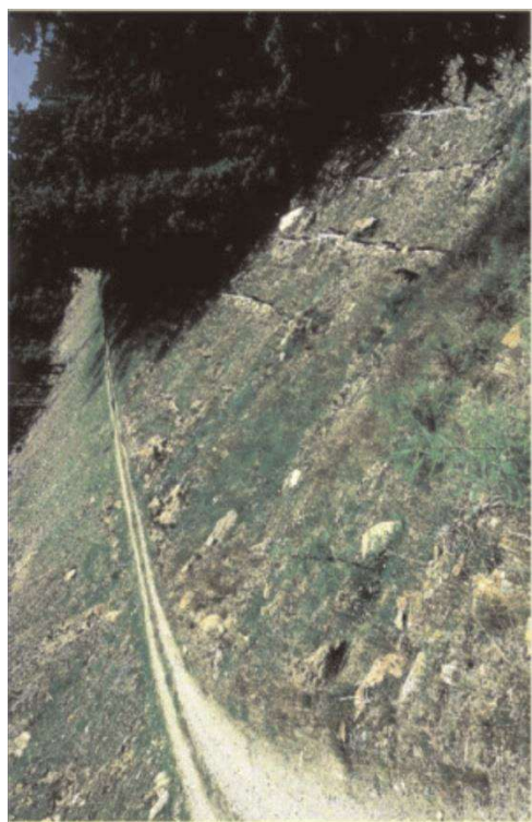
Palizzata in legname ed inerbimento con coltre protettiva di paglia e bitume (dopo 8 anni)
