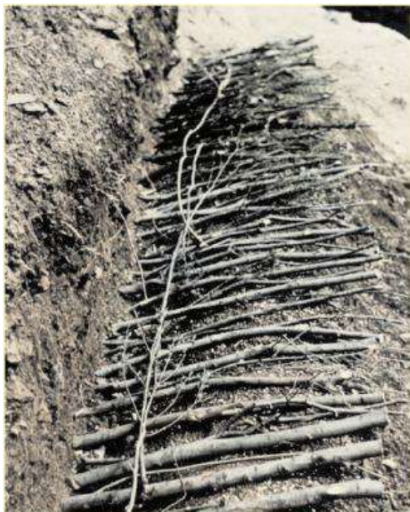
Gradonata con talee (fase di realizzazione)
